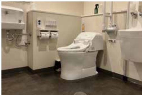
多機能トイレ Multifunctional toilet
